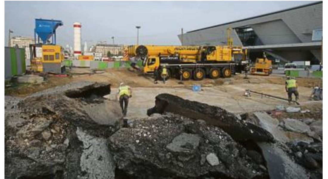
Porte Maillot, un forage d'essai a percé la voûte du tunnel du RER A, la ligne la plus fréquentée d'Europe, avec 1,2 million de passagers par jour. Photo Gely/Sipa
